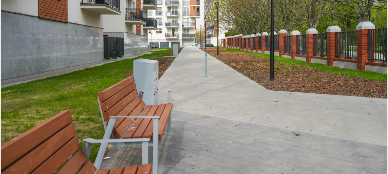
Ilustracja 3.5: Nowo wybudowany ciąg pieszy pomiędzy ulicami gen. Franciszka Kleeberga i gen. Tadeusza Kutrzeby
