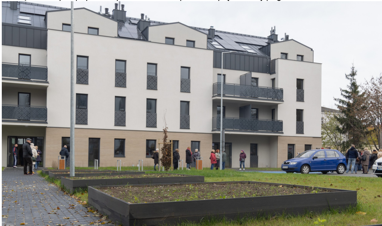
Ilustracja 7.3: Budynek przy ul. Henryka Sienkiewicza 21 powstał z myślą o realizacji programu "Mieszkanie dla seniora"
