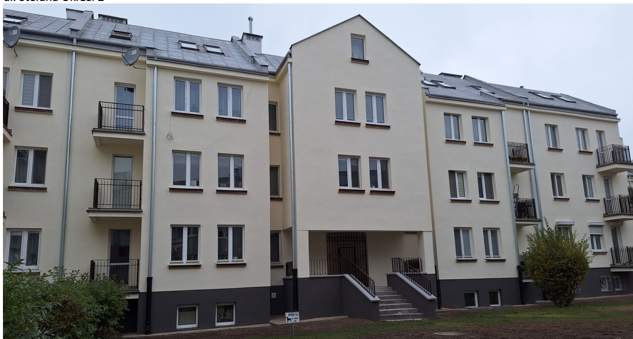
Ilustracja 10.2: Wyremontowana dzięki dotacji z Budżetu Miasta Płocka elewacja od strony dziedzińców budynku przy ul. Stefana Okrzei 2
