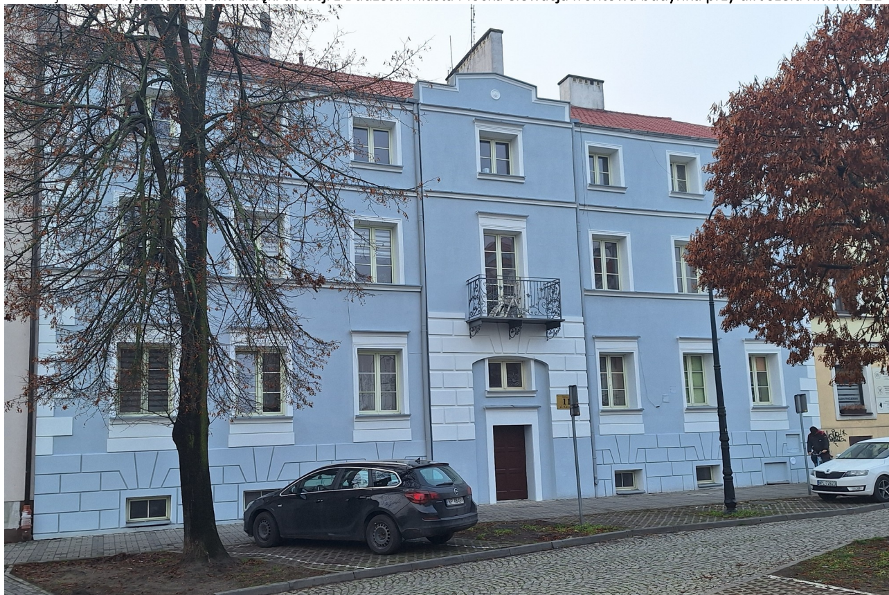
Ilustracja 10.1: Wyremontowana dzięki dotacji z Budżetu Miasta Płocka elewacja frontowa budynku przy ul. Józefa Kwiatka 11
