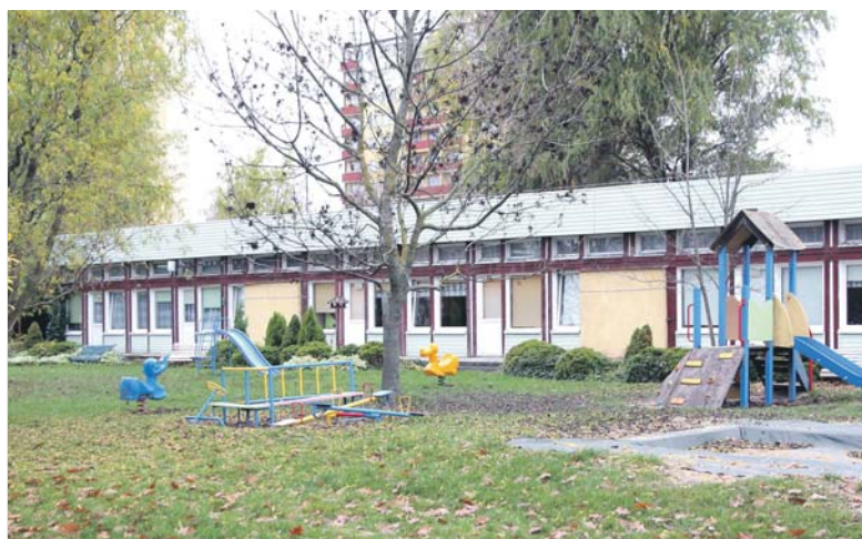
MP nr 27 przy ul. Reja to ostatnie przedszkole wybudowane w tzw. „systemie ciechanowskim”
