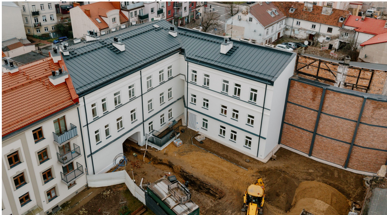
Ilustracja 7.1: Budynek mieszkalny wielorodzinny przy ul. Sienkiewicza 48 w trakcie remontu
