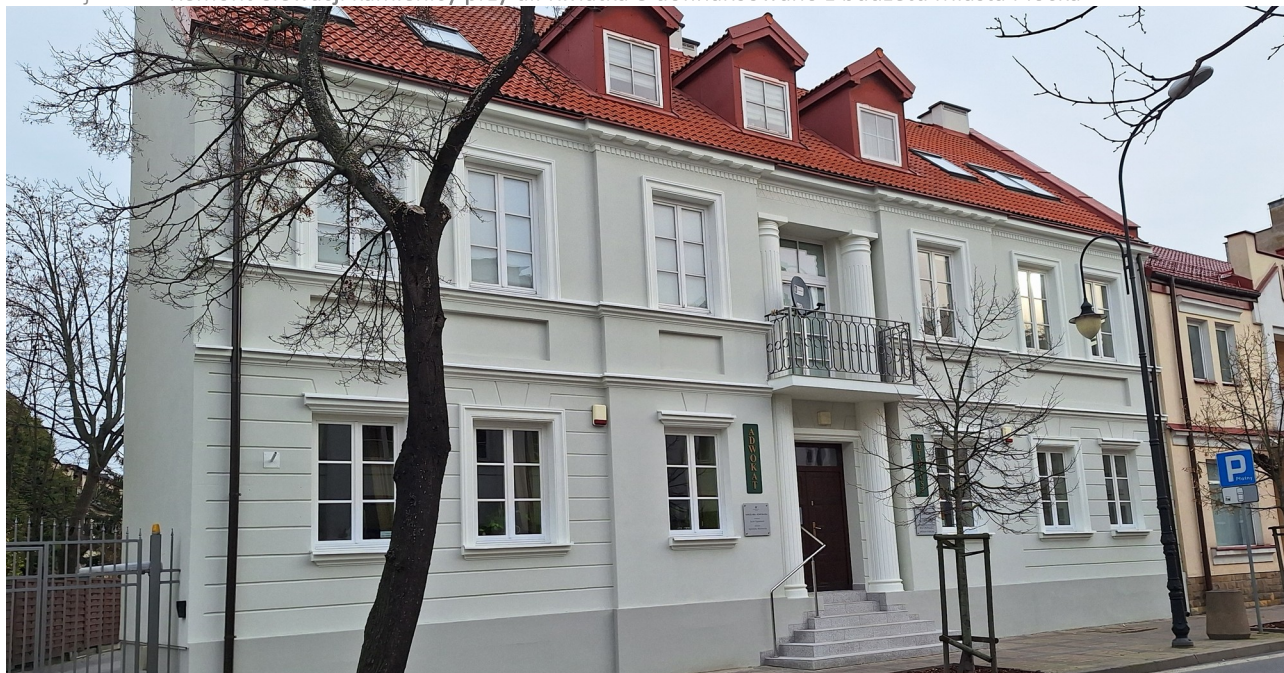
Ilustracja 10.3: Remont elewacji kamienicy przy ul. Kwiatka 8 dofinansowano z budżetu Miasta Płocka
