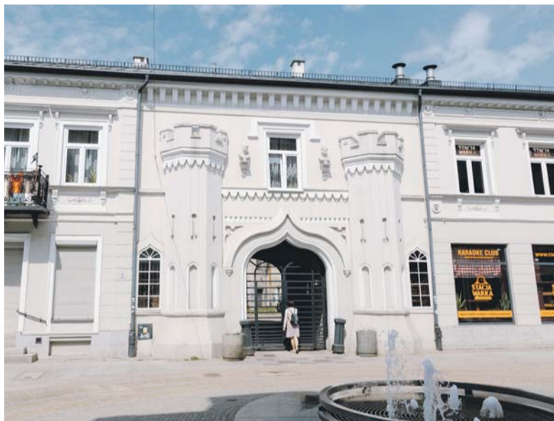
Budynek przy ul. Tumskiej 9
