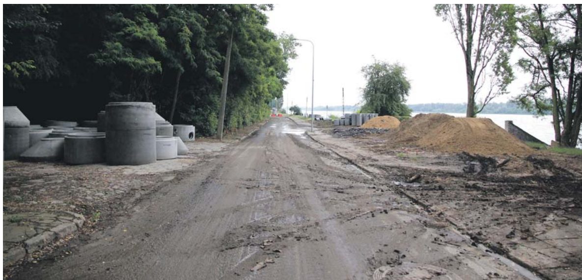
Prace przy modernizacji drugiego fragmentu bulwarów już trwają
