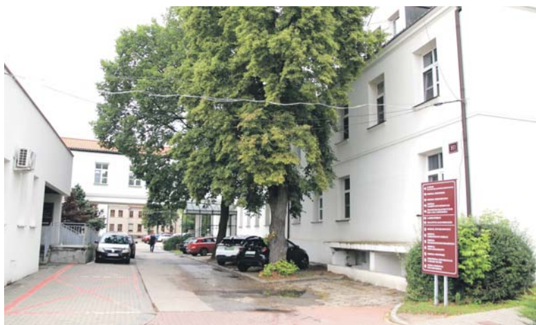
W ramach inwestycji zostanie przebudowana droga wewnętrzna między budynkami H i K
