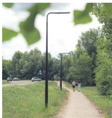
W pierwszym etapie zamontowanych zostało 55 nowoczesnych latarni
