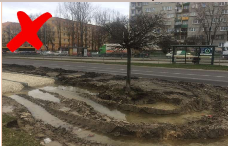
ZALANIE I ZAGĘSZCZENIE powoduje brak dostępu tlenu do korzeni i ich zamieranie
