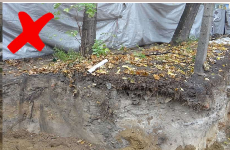
PRZESUSZENIE KORZENI W WYKOPIE powoduje wysychanie korzeni żywicielskich i ich zamieranie
