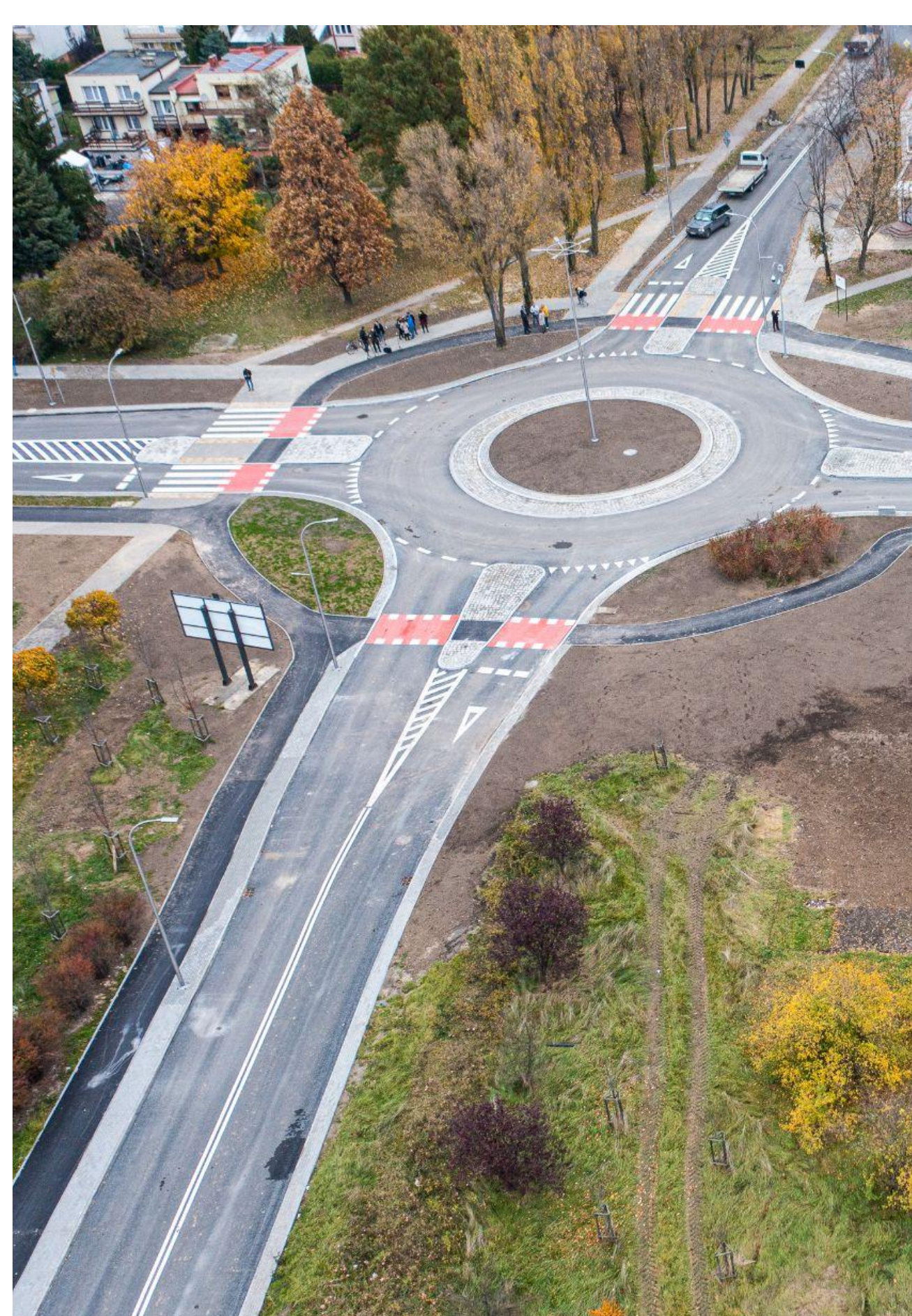
Nowe rondo wybudowane podczas remontu ul. Chopina. Kolejnym etapem będzie przebudowa ul. Spółdzielczej
