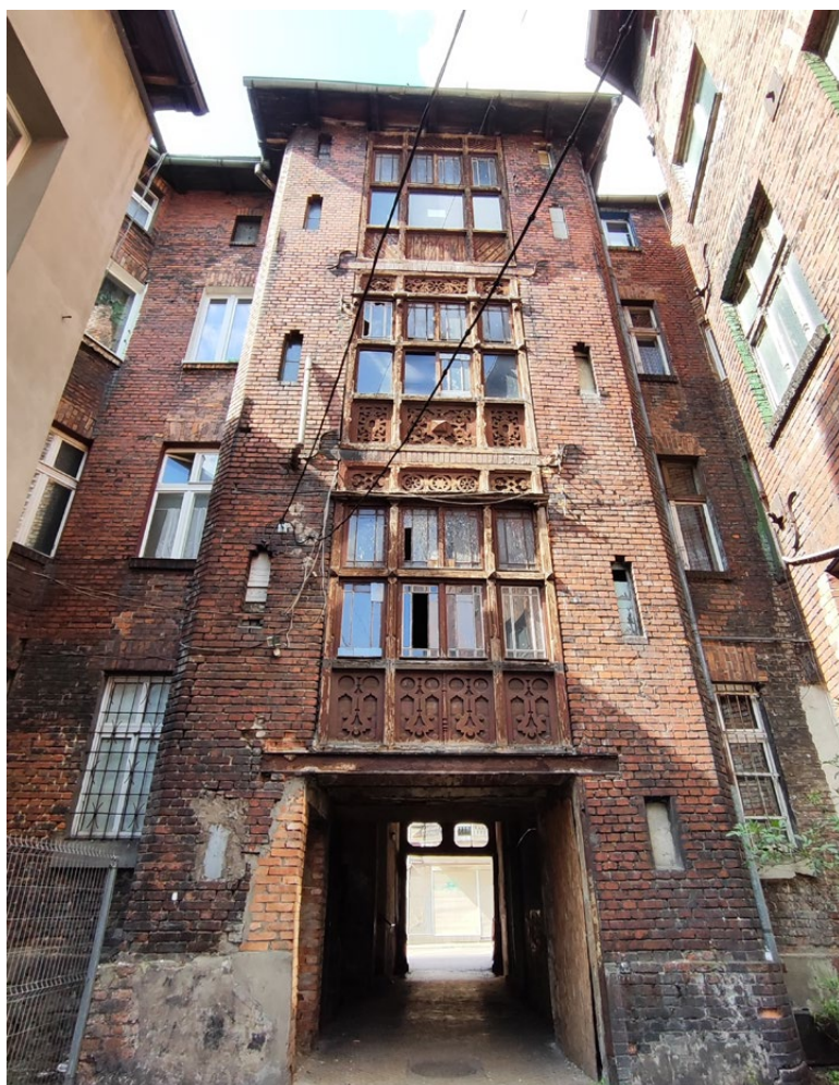
Unikatowa drewniana zabudowa klatki schodowej z bogatym detalem snycerskim na elewacji podwórkowej kamienicy z końca XIX wieku, Bytom
